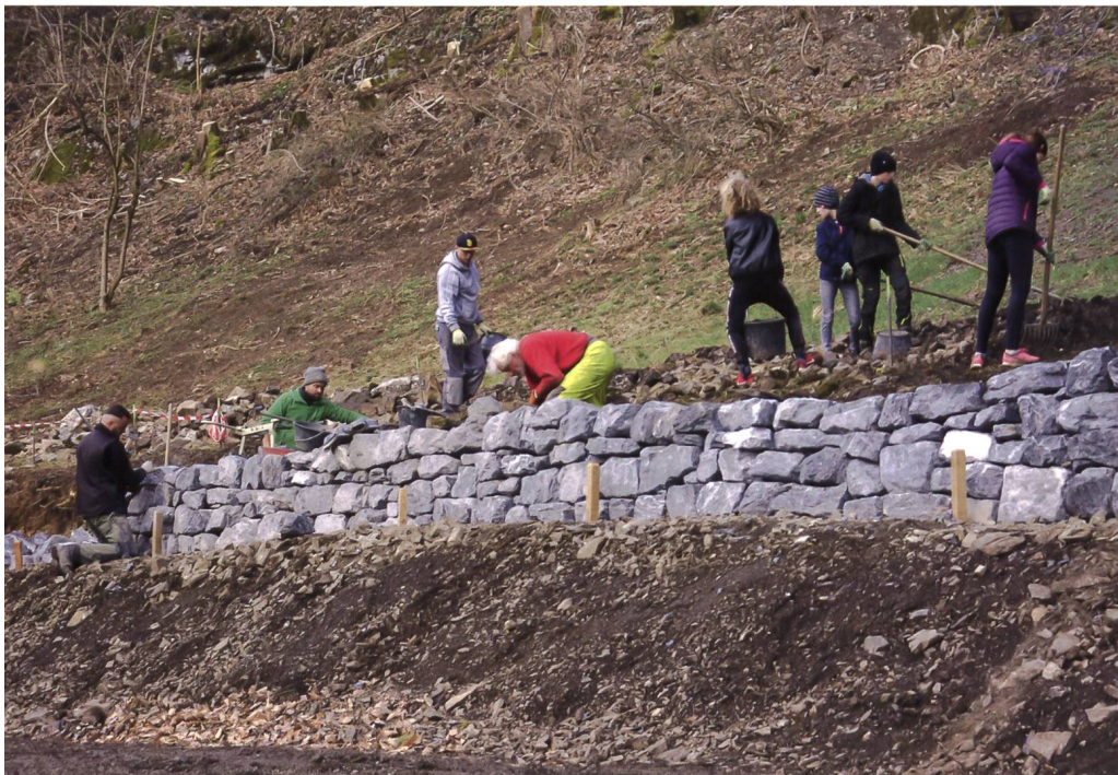
Eine Trockenmauer hat Stützfunktion und ist vielfältigster Lebensraum für Tiere und Pflanzen. In dreiwöchiger Arbeit wurden die Reste der alten Mauer ab- und mit 55 Tonnen Kalkstein aus Balzers neu aufgebaut. Vom Kindergarten bis zur Oberstufe gab es für die Kinder und Jugendlichen Möglichkeiten zur Mitarbeit.
