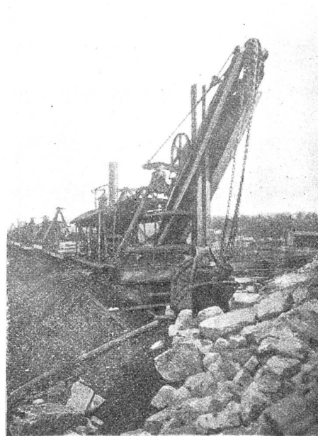
Abbildung 39. Dampfschaufel am Chicago-Entwässerungs-Kanal.
