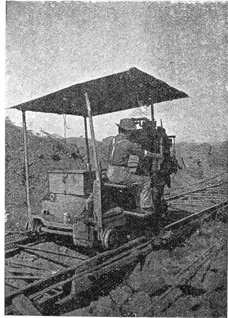
Abbildung 38. Maschine zur Herstellung vertikaler Schlitzte. Antrieb mit Pressluft.
