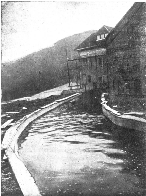
Die Wasserkraftanlage Siegesmühle bei Seon. Abbildung 1. Oberwasserkanal in Eisenbeton.
