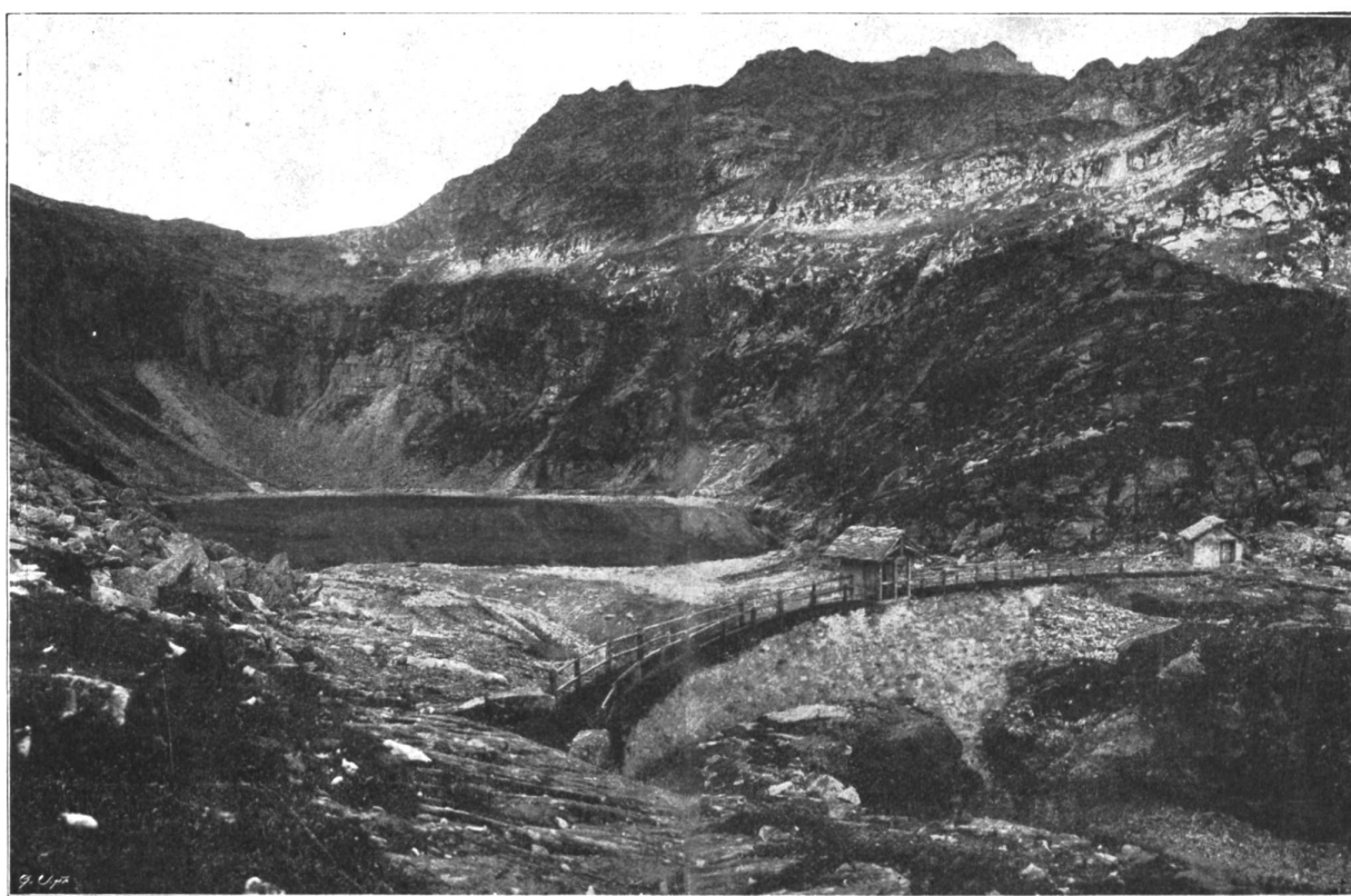
Abbildung 3. Chironico-See mit Stauanlage.
