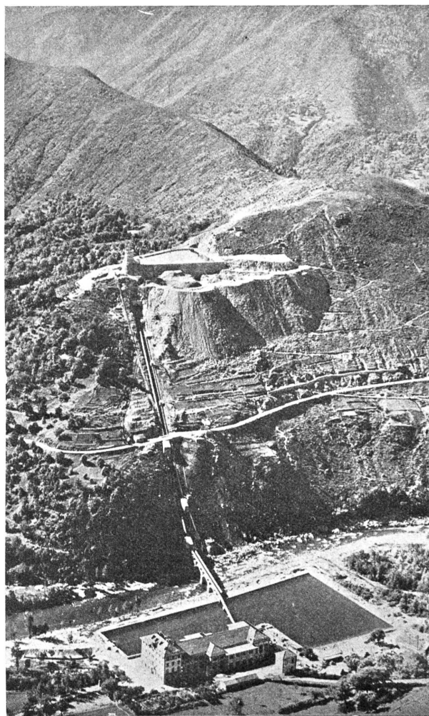
Hydraulische Akkumulierungs- und Pumpenanlagen. Figur 1. Oberes und unteres Bassin der Anlage Stura di Viù.
