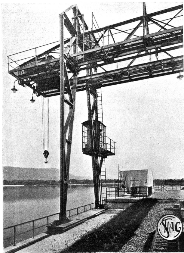
Das elektrische Hebezeug beim Bau und Betrieb von Kraftwerken. Figur 4. Pendelstütze am Sechstonnen-Bocklaufkran im Kraftwerk Augst. Erbauer: Maschinenfabrik St. Jakob A.-G. in Basel.
