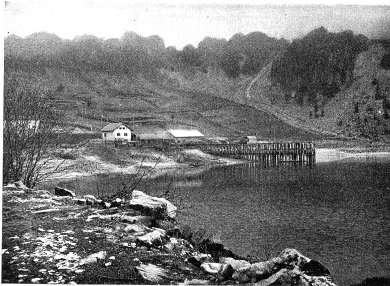
Abbildung 3. Heberanlage vom Ufer aus gesehen bei gesenktem Seespiegel.
