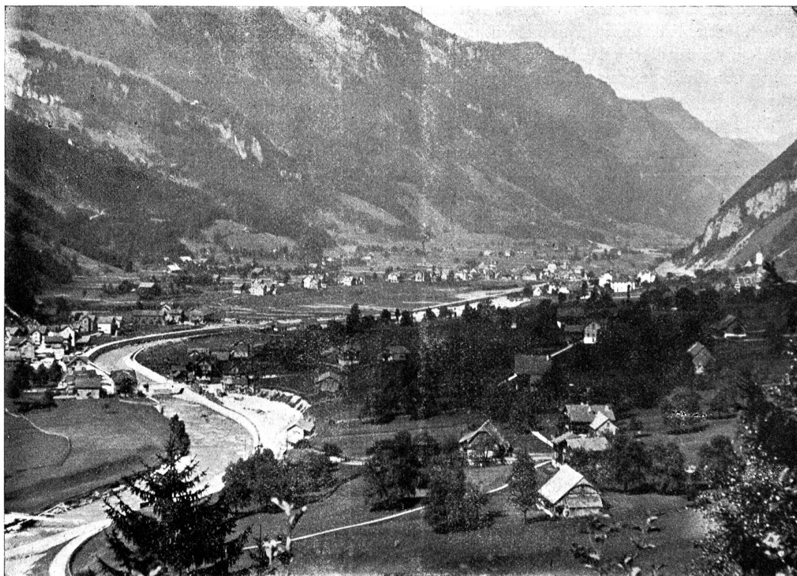
Die Muotakorrektio.n. Abb. 8. Korrektionsstrecke Starzlenmündung bis Muotathal, km 0 + 800 — km 2 + 600
