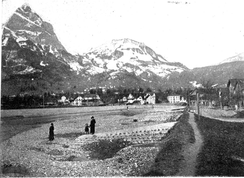
Die Muotakorrektio. Abb. 27. Armierte Betonsporren für Ufersicherung und Verlandung.
