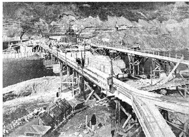
Abb. 6. Gesamtansicht der Wehranlage im Bau.
