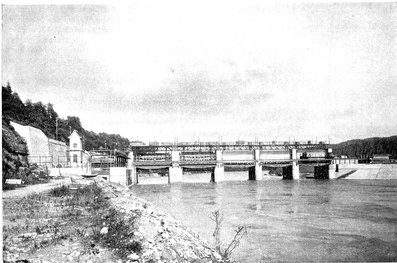
Abb. 11. Ansicht der Wehranlage von der Oberwasserseite im Oktober 1913.
