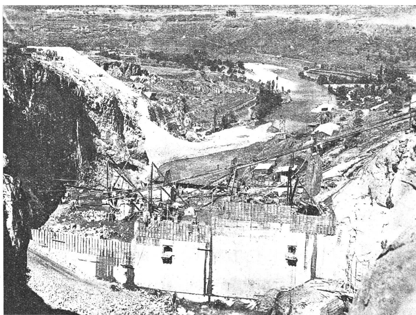
Abb. 10. Blick flussabwärts auf die Staumauer, rechts unten Einlauf in den Umgehungsstollen und erste Arbeiten zum Abschlussturm.
