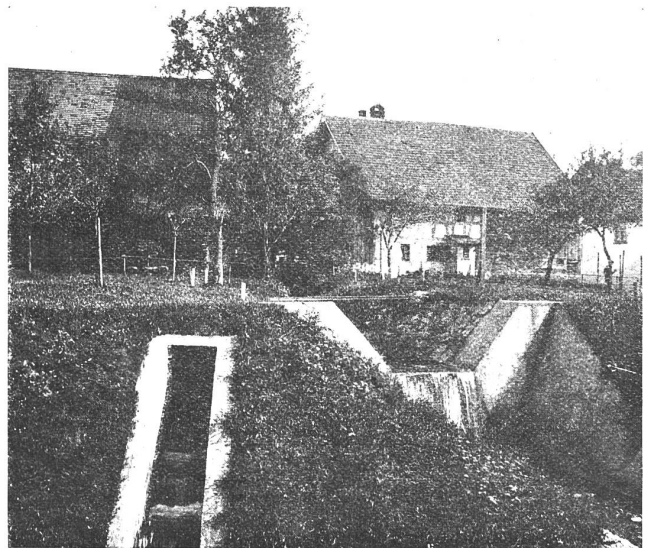
Abb. 23. Absturz der Waltensteiner Eulach in die Elgger Eulach. Ansicht des Fischpasses und des Absturzes.
