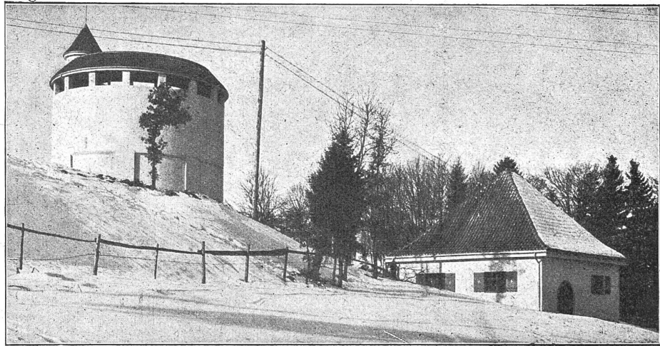
Abb. 5. Das Leitzachwerk, Wasserschloss mit Schieberhaus.
