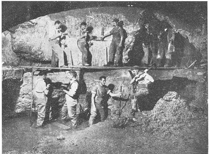
Abb. 10. Arbeit in der oberen Etage der Kammer III.
