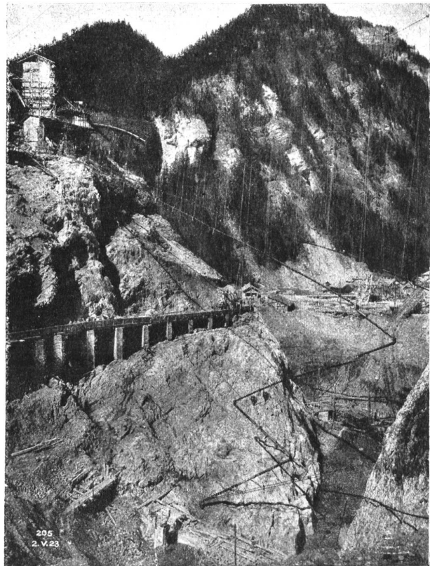
Abb. 3. Kraftwerk Wäggitäl: Betonrinnen zum Bau der Staumauer.
