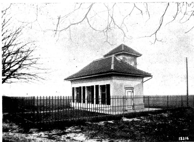
Abb. 11. Pumpwerk Nidaumoos. Ansicht der Anlage.
