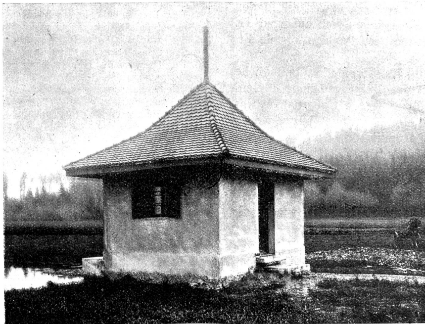
Abb. 27. Pumpwerk Bleienbachmoos. Aeussere Ansicht des Pumpwerkes.
