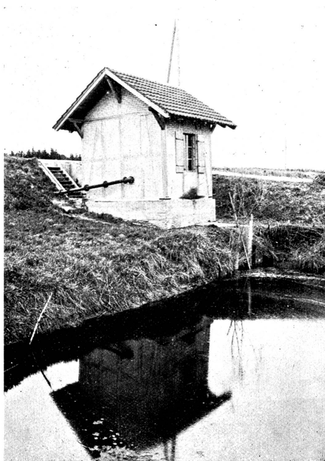
Abb. 29. Pumpstation Hagneck. Ansicht der Anlage.
