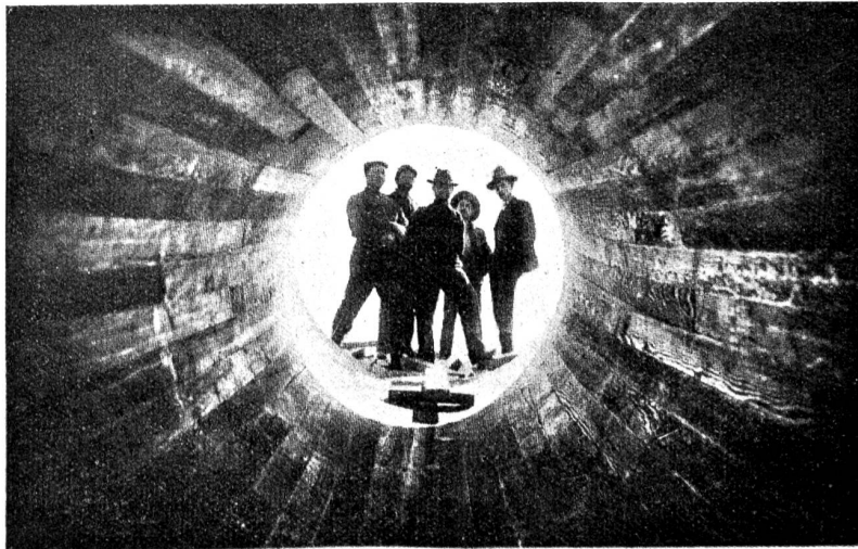
Ansicht der glatten Innenwandung des Holzrohres.
