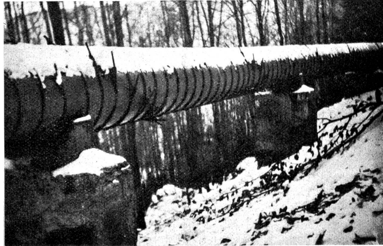
Ueber dem Gelände auf Mauerpfellern verlegte Holzrohrleitung.
