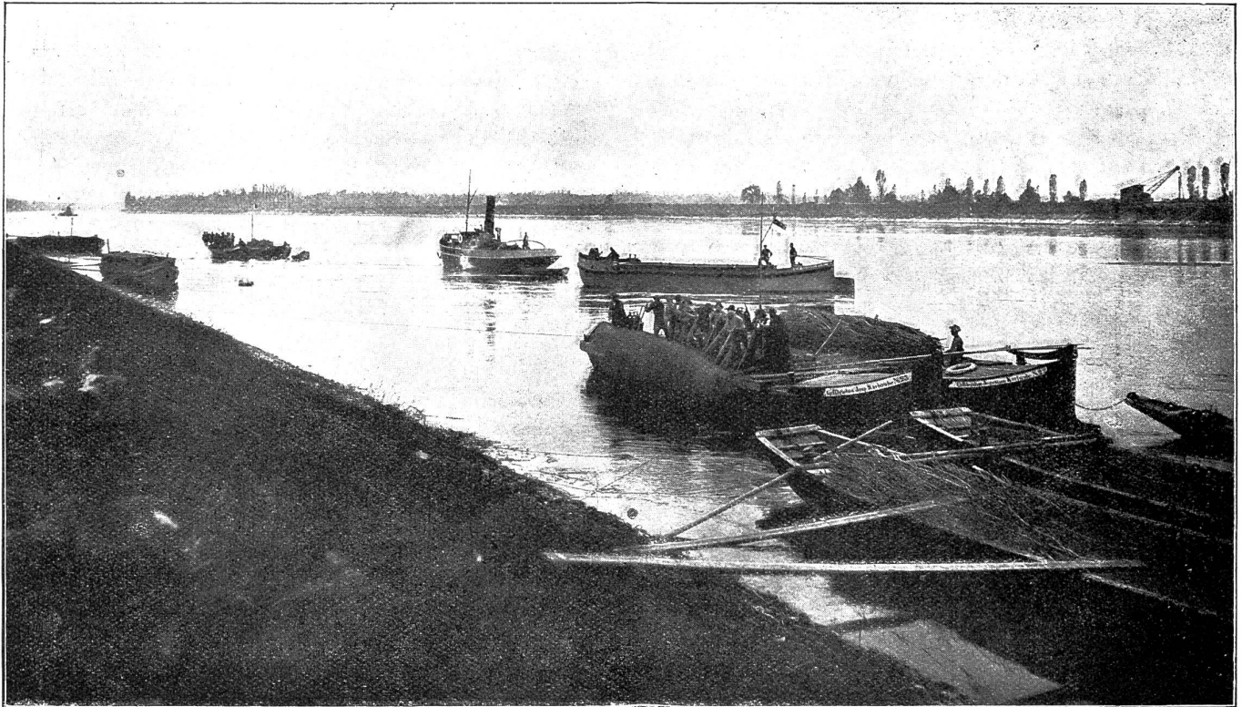
Abb. 4. Senkbrücke aus der Nähe.
