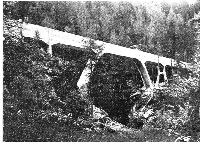
Abb. 13. Vernayaz (S. B. B., im Bau). Aquädukt in Châtelard. (Zuleitung der Eau noire und des Trient.)
