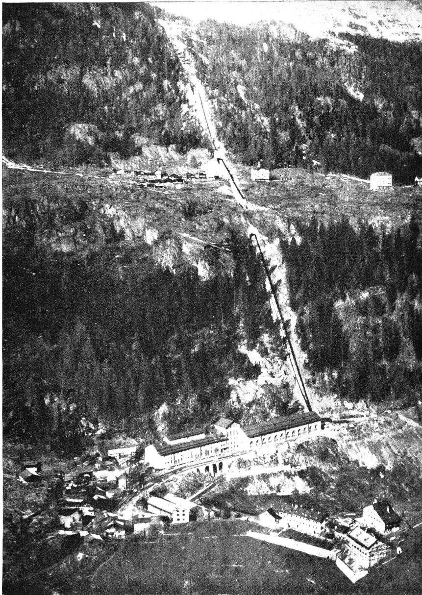
Abb. 11. Barberine (S. B. B., im Bau). Gesamtübersicht.
