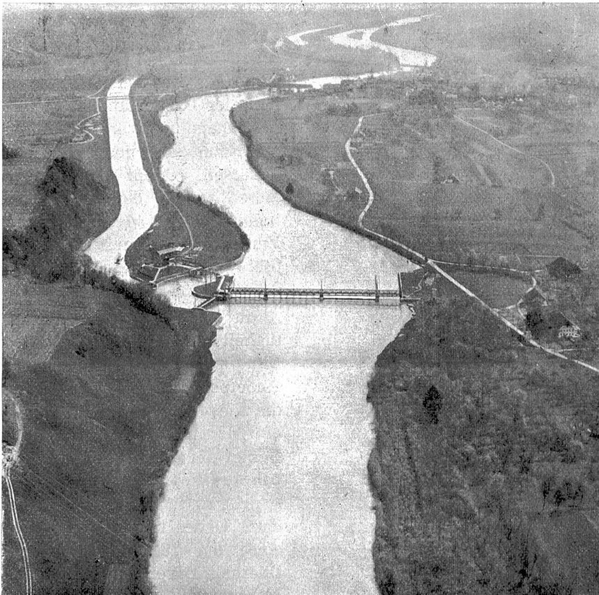
Abb. 2. Elektrizitätswerk Wangen. Wehranlage und Kanaleinlauf.
