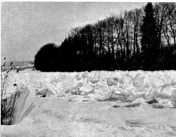
Abb. 7. Elektrizitätswerk Wynau. Eisstoss im oberen Teile des Staugebietes, Schwanau, Bannwil. 12. Februar 1929.
