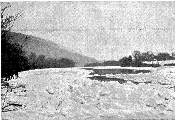
Abb. 12. Elektrizitätswerk Olten-Aarburg. Kraftwerk Ruppoldingen. Eismassen bei Bonigen, flussabwärts gesehen nach Durchbruch.
