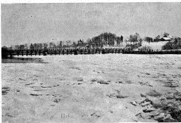
Abb. 10. Elektrizitätswerk Olten-Aarburg. Kraftwerk Ruppoldingen. Eisformation oberhalb des Wehres.
