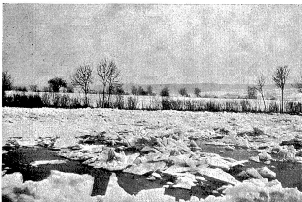
Abb. 13. Elektrizitätswerk Olten-Aarburg. Kraftwerk Ruppoldingen. Eisfeld Bonigen nach Durchbruch.
