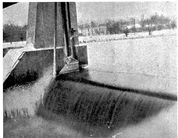
Abb. 31. Kraftwerk Rüchlig. Stauwehr, Öffnung 1 links, von unten gesehen. Wassermenge in der Aare \approx 100 \text{ m}^3/\text{sek} . Der Ueberfall entsteht periodisch durch die Schwankungen, verursacht durch die oben liegenden Werke. 18. Februar 1929.
