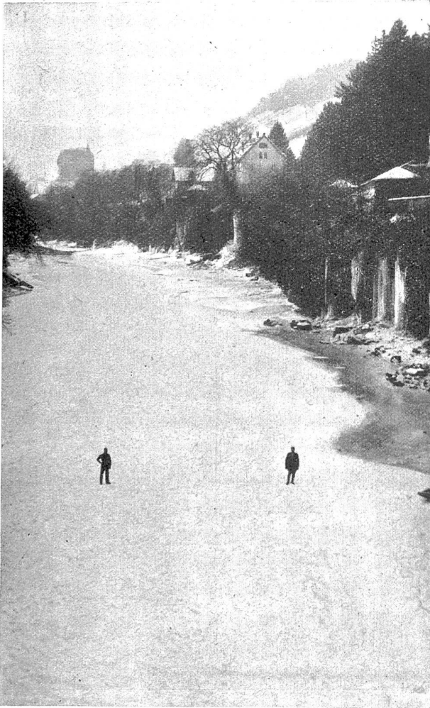
Abb. 35. Elektrizitätswerk der Stadt Brugg. Die zugefrorene Aare unterhalb des Elektrizitätswerkes.
