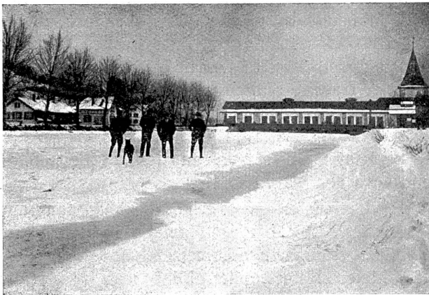
Abb. 23. Elektrizitätswerk der Stadt Aarau, Oberwasserkanal II. 15. Februar 1929.
