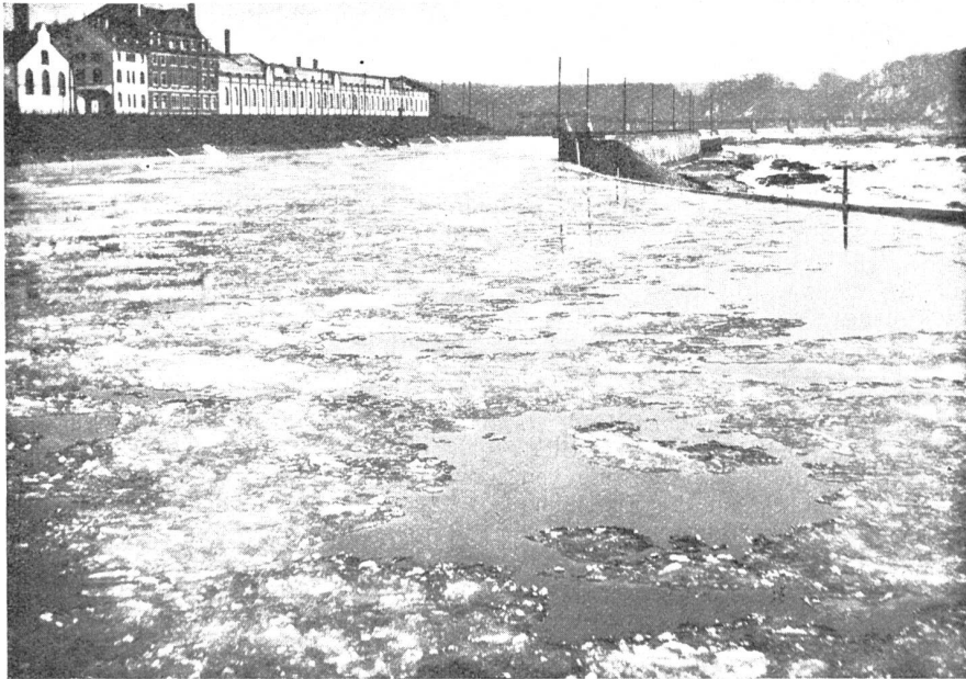
Abb. 41. Kraftwerk Rheinfelden. Eisgang im Oberwasserkanal, aufgenommen von der Kanalbrücke aus. 12. Februar 1929.
