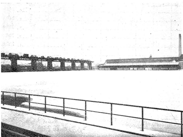
Abb. 53. Kraftwerke Augst-Wyhlen. Oberwasser. 12. Febr. 1929.
