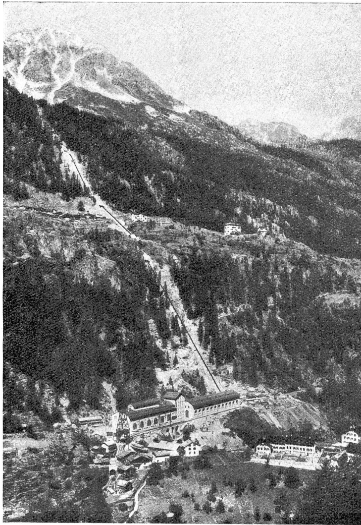
Abb. 7. Kraftwerk Barberine. Zentrale in Chatelard mit Teilstück der Druckleitung.
