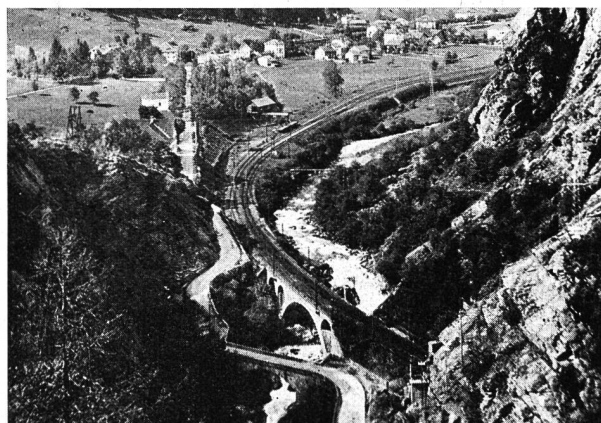
Abb. 2. Kraftwerk Piottino. Die Sperrstelle vor Beginn der Bauarbeiten.
