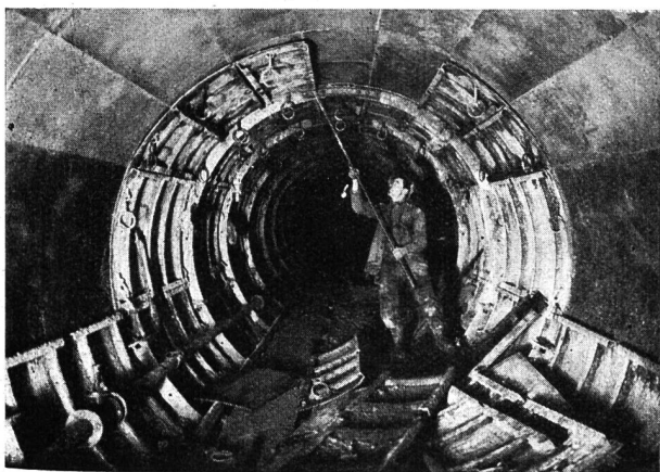
Abb. 8. Kraftwerk Piottino. Ausschalen der Stollenverkleidungen.
