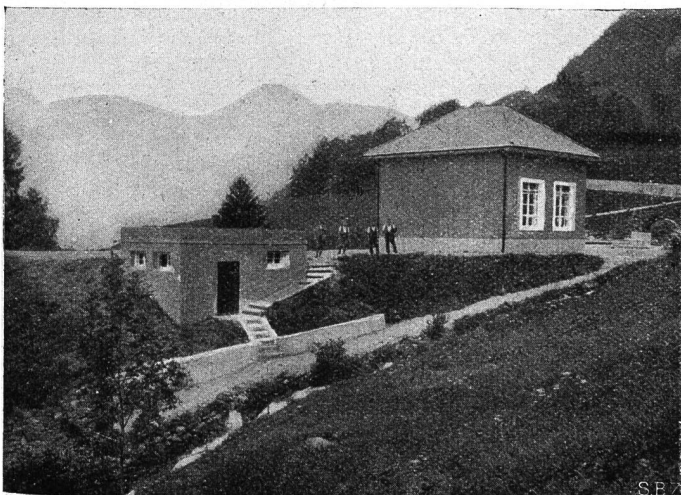
Abb. 8. Der „Meßkeller“ unterhalb des Maschinenhauses.
