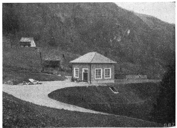
Abb. 7. Maschinenhaus aus Osten gesehen.
