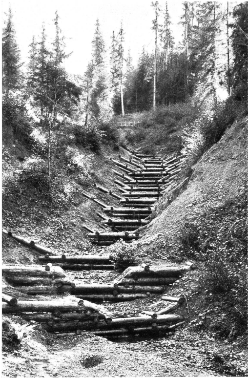
Abb. 9. Klempferergraben bei St. Johann in Tirol — Abtrepfung mit niedrigen hölzernen Grundswellen
