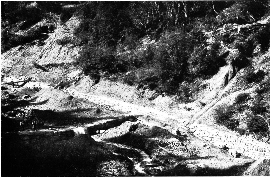
Abb. 27. Siflitzgraben in Oberkärnten — Durch Grundswellen gesicherte Lehnenfußversicherung, im Bau begriffen
