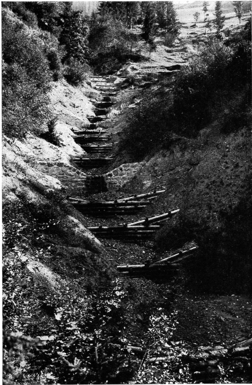
Abb. 11. Meißnergraben bei Hopfgarten, Nordtirol — Abtreppung mittelst Stein- und Holzsperrn
