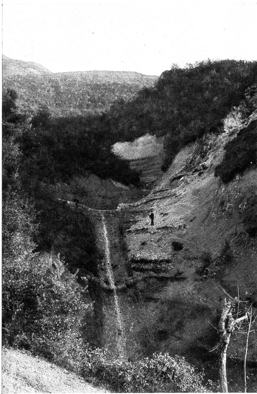
Abb. 17. Rivo Sornell bei Lavis, Südtirol — Schalenbau zur Sicherung einer steilen Grabenpartie gegen Erosion
