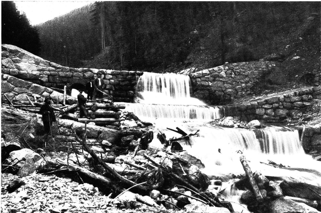
Abb. 23. Märzenbach, Zillertal, Nordtirol — Konsolidierungssperre mit zwei Vorsperren
