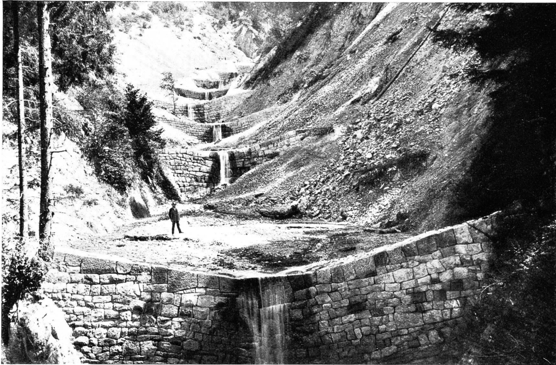
Abb. 25. Gödnacherbach in Osttirol — Mittelst trockengemauerten Sperren abgetreppte Grabenpartie.
