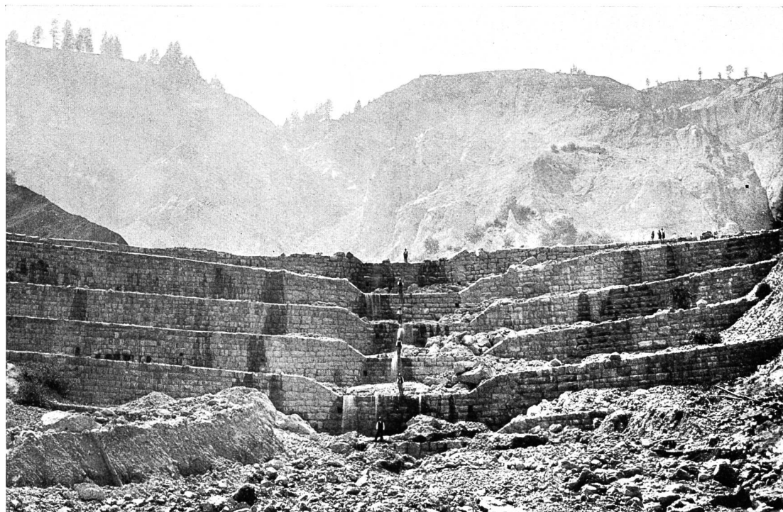
Abb. 30. Schesatobel bei Bludenz, Vorarlberg — Blick auf die oberste Sperrenserie, letzte Sperre noch unvollendet
