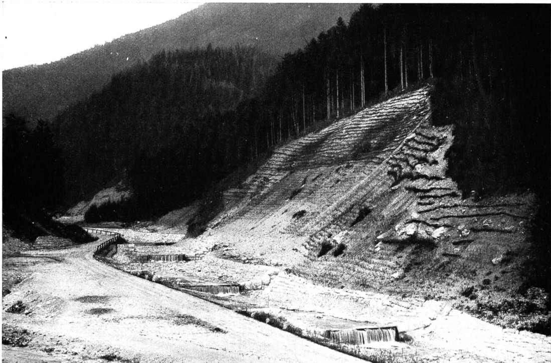
Abb. 28. Langbathbach bei Ebensee, Oberösterreich — Durch Quer- und Längsbauten gesicherte Bachstrecke, Bruchfläche bepflanzt
