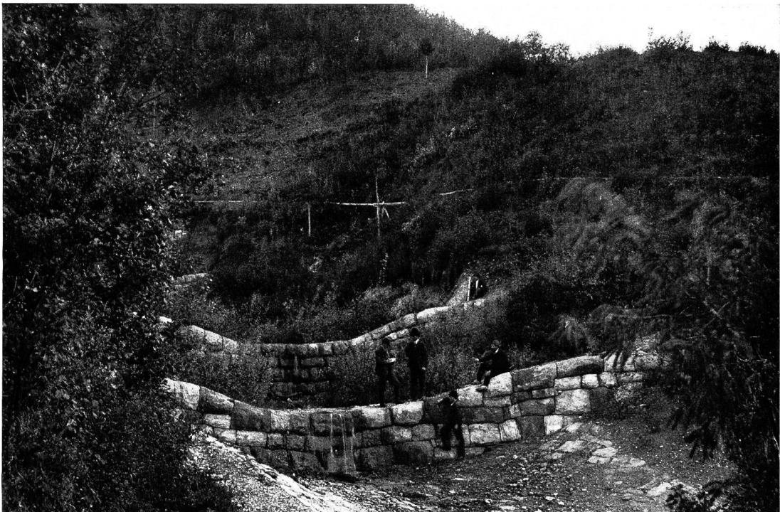
Abb. 26. Rivo Sornell bei Lavis, Südtirol — Mittelst Sperren verbaute Grabenpartie Bruchflächen bereits bewachsen
