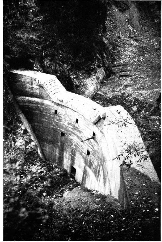
Abb. 8. Galgentobel bei Bludenz, Vorarlberg — Sperre in Stampfbeton, Abflußsektion mit Steinkrone und Wassernase
