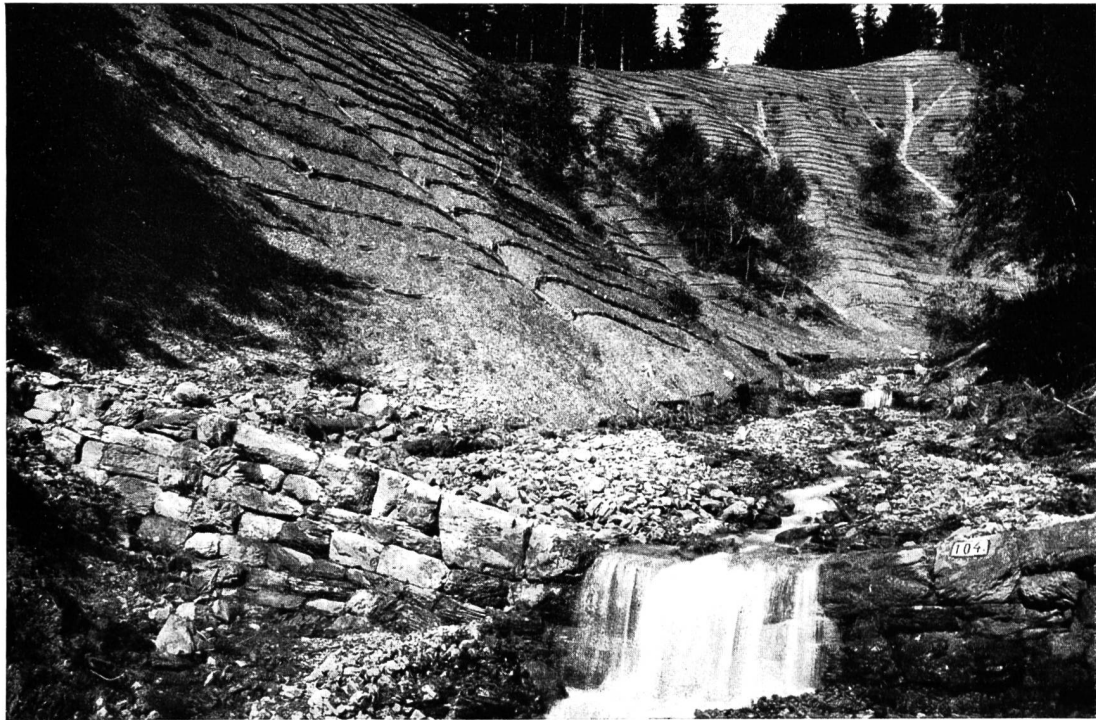
Abb. 31. Schmittenbach bei Zell am See, Salzburg — Verbaute Bruchfläche im Finsterbach im Jahre 1888
