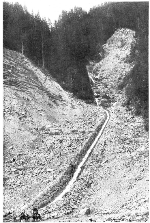
Abb. 18. Rivo Majo, Fleimstal, Südtirol — Schale zur Abhaltung des Baches vom Bruchflächenfuße
