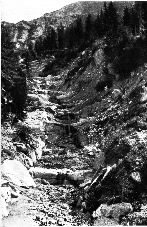
Abb. 13. Naifbach bei Meran, Südtirol — Runsenverbauung mittelst gemauerten Quers- und Längsbauten
