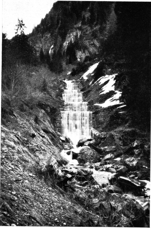
Abb. 19. Ratzbach bei Weiler, Vorarlberg — verbaute Grabenpartie im Oberlaufe
