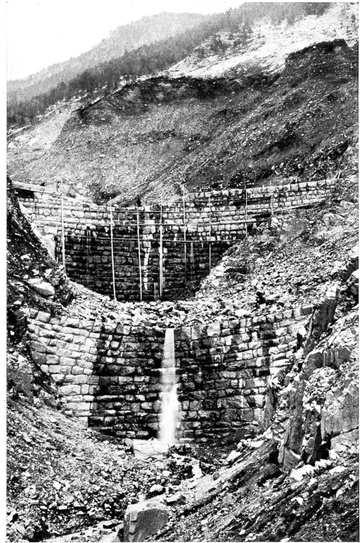
Abb. 6. Bruchfläche von Sette fontane, Cembratal, Südtirol — Konsolidierungssperren in Zementmörtel-Mauerwerk
