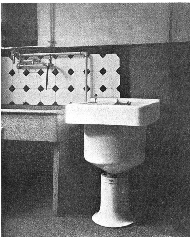
Abb. 23 «SOS» Geschirrwashmaschine mit Anschluss an Boiler.
