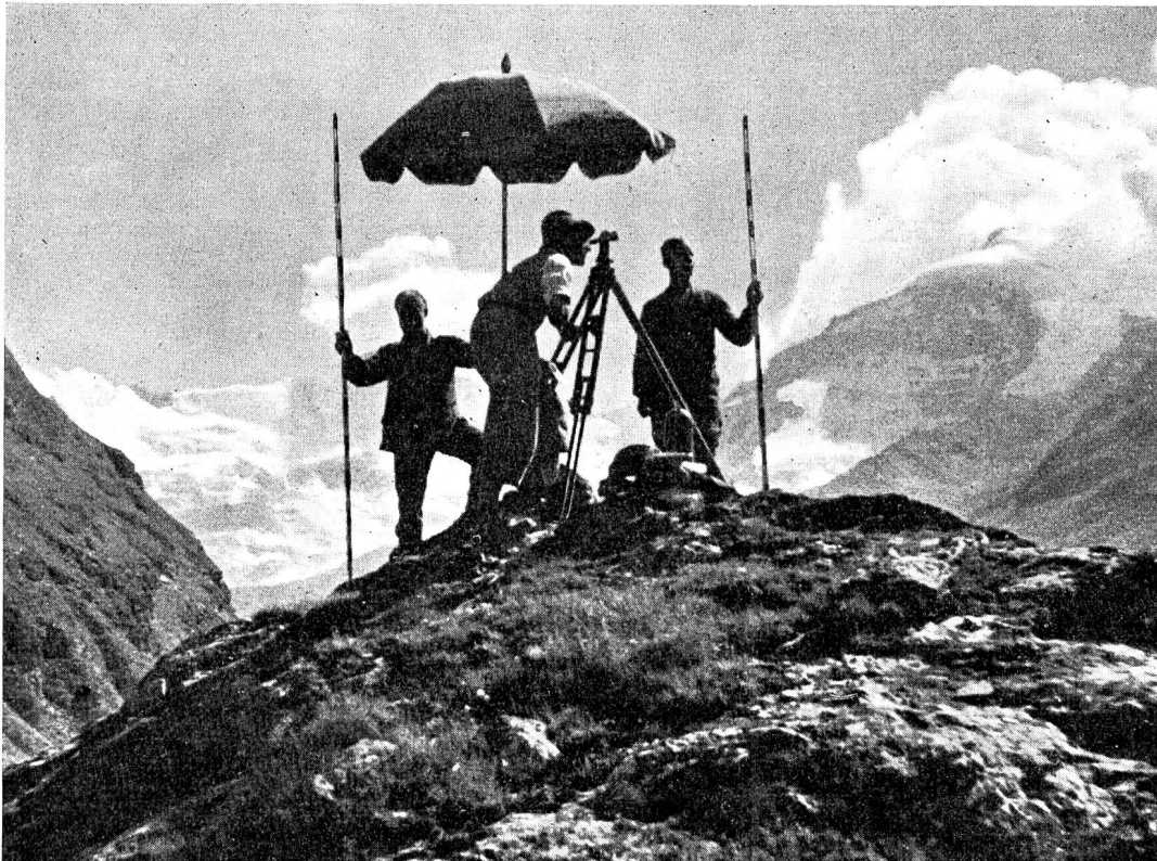
Abb. 35 Geometer bei Vermessungsarbeiten für den Bau der Dixence-Talsperre (Wallis). Aus dem Film: «Unsichtbare Kraft».
