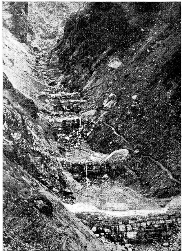
Abb. 47 Guppenruns bei Schwanden. Sperrerbauten in der Sienschlucht.
