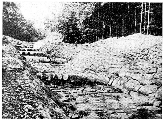
Abb. 48 Schalenbau am Biltener Dorfbach.
