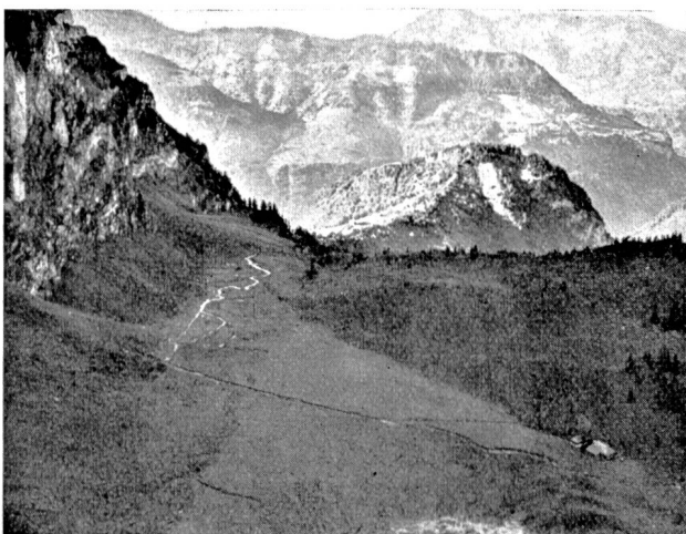
Abb. 49 Bannalpwerk Blick über die Bannalp (Dammbaustelle) gegen Westen. (Photogr. Aufnahme der Firma Leupin & Schwank Bern, 1930.)
