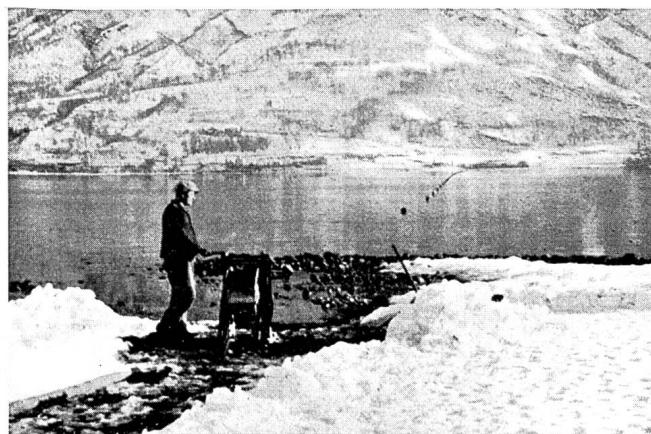
Abb. 107 An Schwimmern aufgehängter Messdraht. (Maggia-Delta-Aufnahme).
