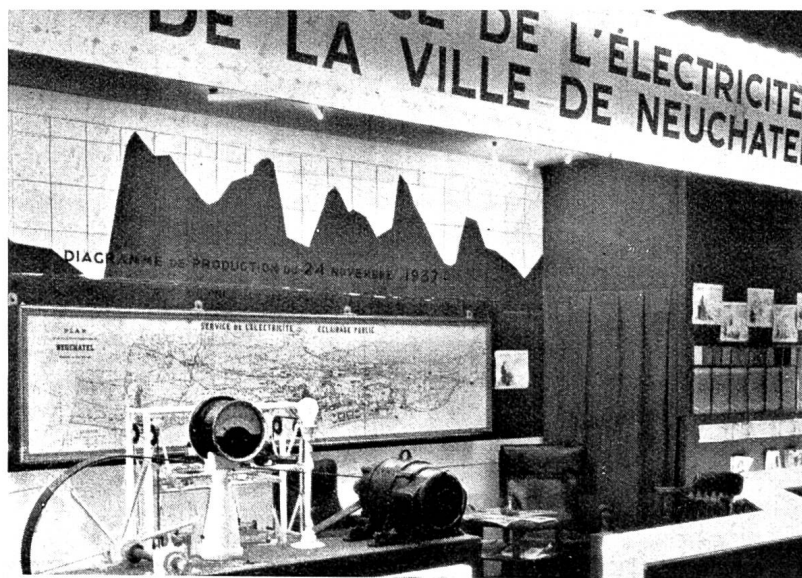
Fig. 22 Comptoir de Neuchâtel: Stand du Service de l'Electricité de la Ville de Neuchâtel. Comptoir Neuenburg: Stand des Elektrizitätswerks der Stadt Neuenburg.
