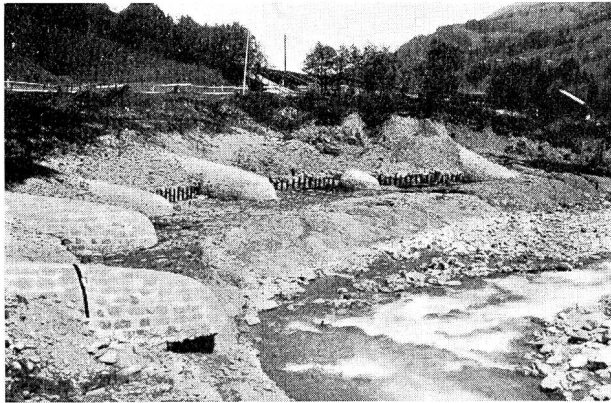
Abb. 21 Engstligen in Adelboden am 29. Mai 1934. Verbauung mit «Schildkröten». Eidg. Oberbauinspektorat.
