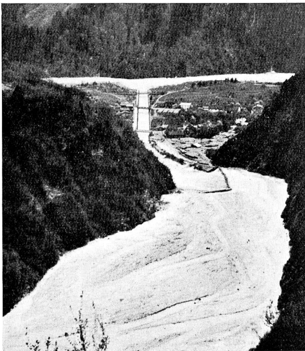
Abb. 15 Geschiebeführung des Schraubaches in der Mündungsstrecke bei Schiers 1933. Eidg. Oberbauinspektorat.
