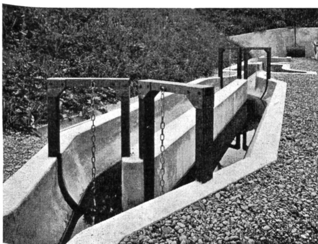
Abb. 4 Ansicht des Sandfanges, gegen Fliessrichtung gesehen.
