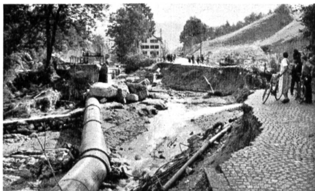
Abb. 4 Folgen der Ueberflutung der Seitenmauer des Stauweihers im Tiefenhof, Wald.
