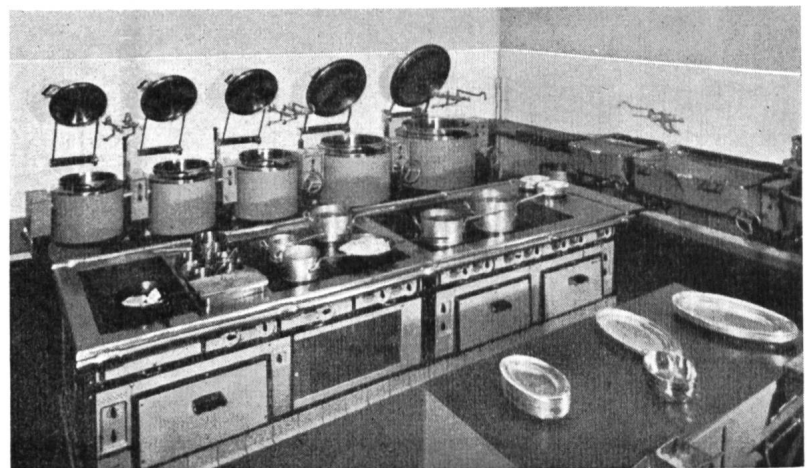
Fig. 21 Kochherd, Kippkessel- und Bratpfannengruppe. Cuisinière électrique, poste des marmites basculantes et les poêles à frire.
