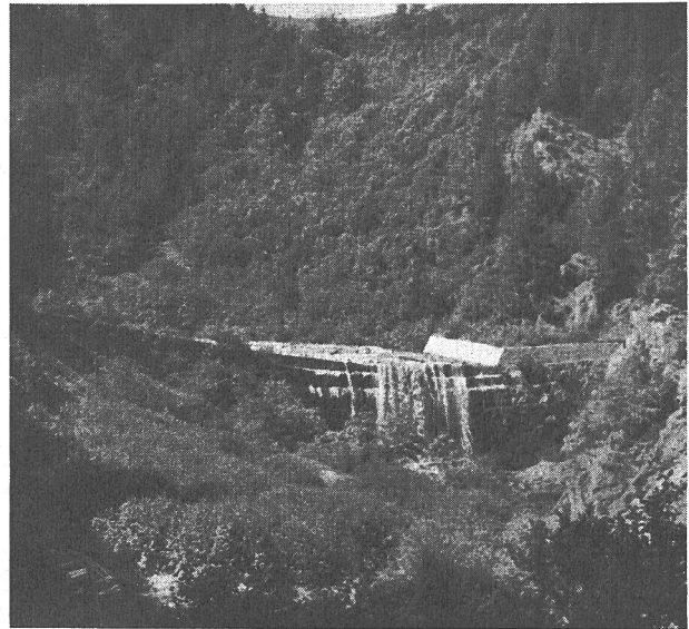
Abb. 3 Nollaverbauung. Sperre I, Zustand 1939. (Nr. 5045 BRB 3. X. 1939)
