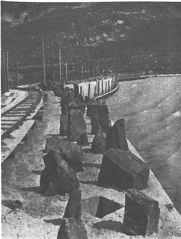
Abb. 10 Lago-Bianco-Mauer; Ausbau 1941 fertig; Anschluss für definitive Erhöhung; vorn Dilatationsfuge.
