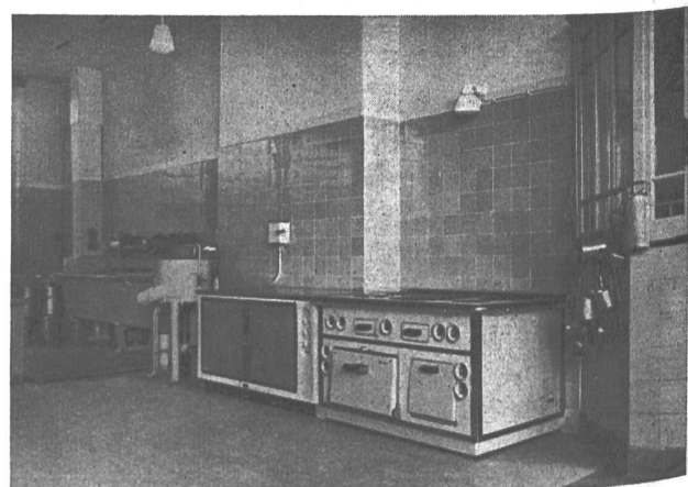
Fig. 49 Angestelltenküche mit Wärmeschrank und Herd. La cuisine des employés avec armoire chauffante et cuisinière.
