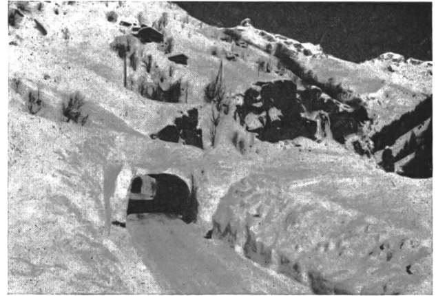
Abb. 3 Kraftwerk Gampel III. Rücklauf-Schneetunnel zwischen Goppenstein und Wasserfassung. Es mussten über 300 Meter Schneetunnel auf der Talstrasse erstellt werden. (Nr. 6398 BRB 3. 10. 39.)
