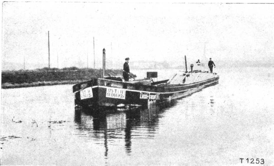
Abb. 6 Akkumulatoren-Lastkahn für 180 t Nutzlast auf den Berliner Gewässern.
