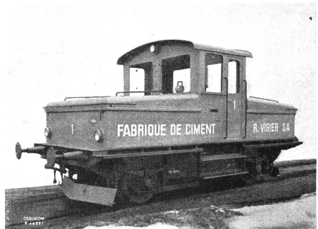
Abb. 2 Moderne Werklokomotive 100 PS, Aktionsradius 6400 tkm. Gewicht 25,5 t.
