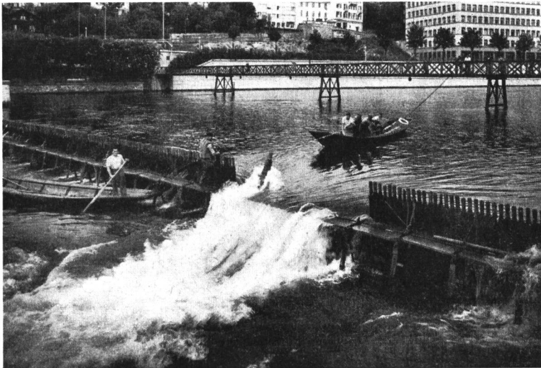
Abb. 1 Altes Kraftwerk Letten, Nadelwehr. (No. 6398 BRB 3. 10. 39)
