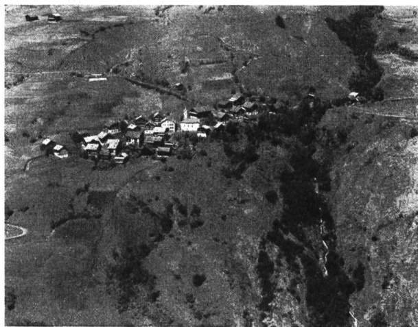
Abb. 3 Das am meisten gefährdete Dorf Peiden. Photo: Jules Geiger, Flims. (No. 6898 BRB 3. 10. 39)
