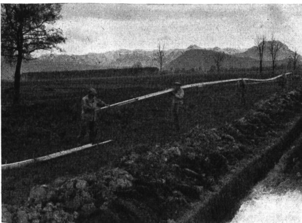
Abb. 6 Melioration der Rheinebene. Holzkastendrain.
