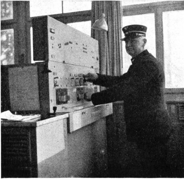
Fig. 1 Das neue, vollelektrifizierte Stellwerk im Bureau
