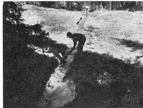
Abb. 4 Wasserführungsarbeiten beim Rüfenwald unter der Saaser Alp. Der gefährliche Bach floss vorher über den Hang (im Vordergrund nach rechts, Doppelpfeil) und versickerte bis auf zirka 80 m Länge am unteren Steilhange. Er wurde 1945 in neuer Bachrinne ins nächste Tobel geleitet (Pfeilrichtung).
